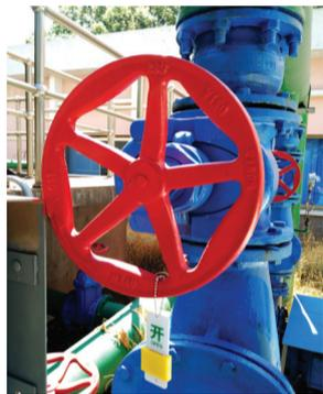
开关标示牌（通过悬挂“开”、“关”指示牌，避免了无刻度盘阀门开闭状态误判，保障了生产运行的稳定性和安全性。）
