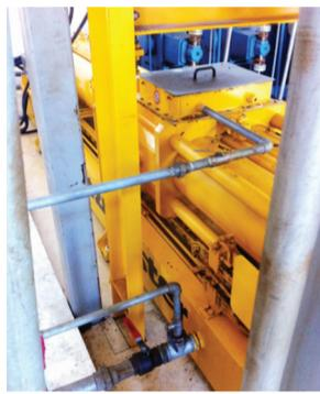
柱塞泵冷却水箱自动换水装置（优化柱塞泵冷却水箱注水方式，实现24小时不间断，夏季恒温至20℃左右，大大节约了泵机维护和用水成本。）
